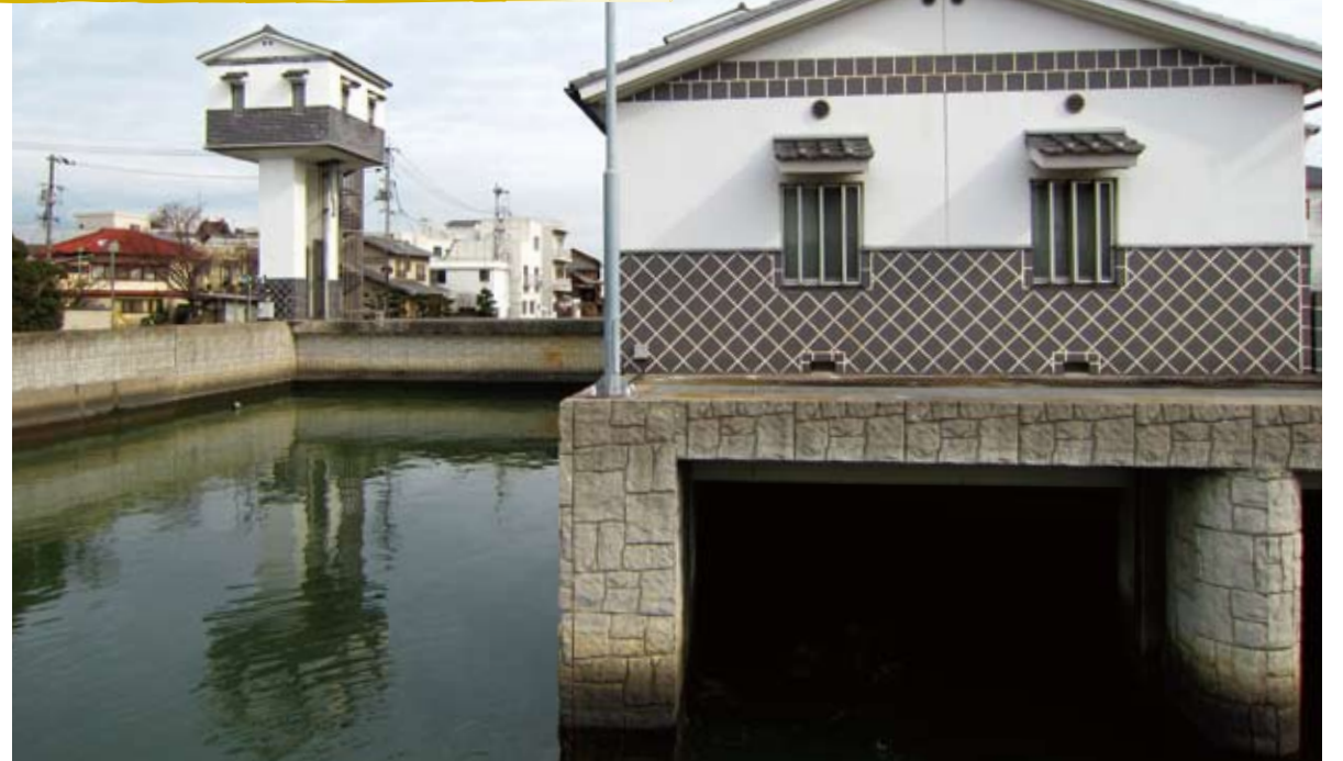
蔵がある街らしく、溜川排水機場と新港水門も蔵のデザイン
