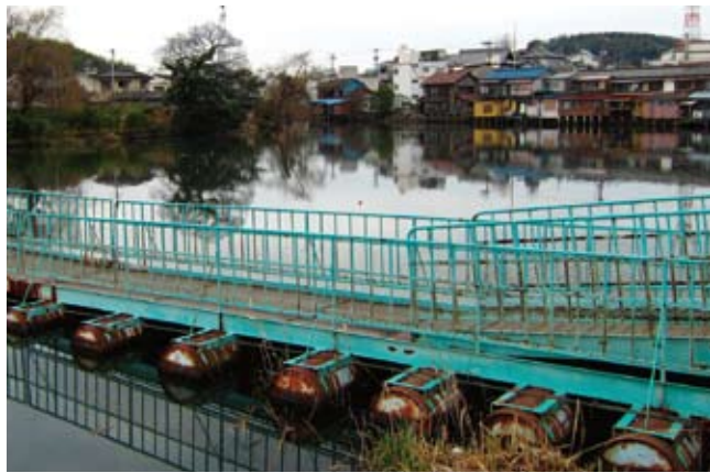
ドラム缶の浮き橋の向こうには、水面にせり出した民家が
