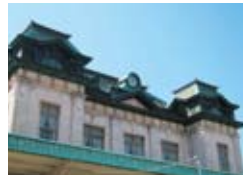
JR門司港駅。駅舎は国の重要文化財で、現在は大規模改修工事中
