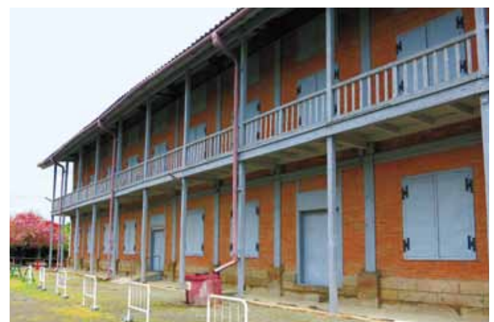
フランス積みのレンガが美しい東繭倉庫。敷地内ほとんどの施設が国重要文化財
